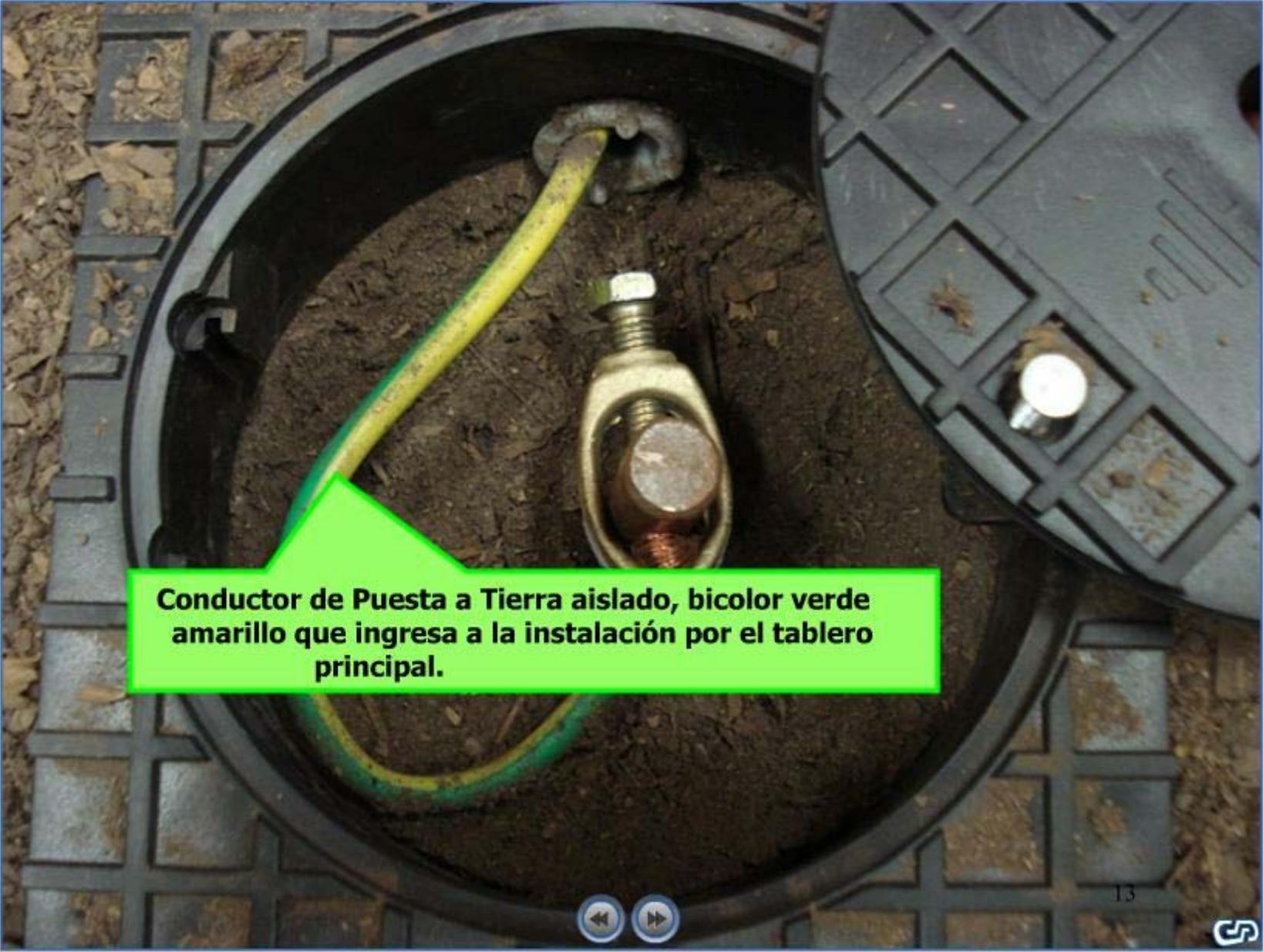
**Conductor de Puesta a Tierra aislado, bicolor verde amarillo que ingresa a la instalación por el tablero principal.**
