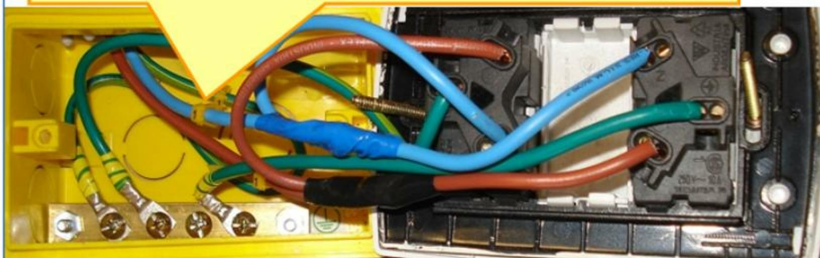
**Conexión de los módulos de tomacorrientes, respetando la polaridad y el código de colores**
