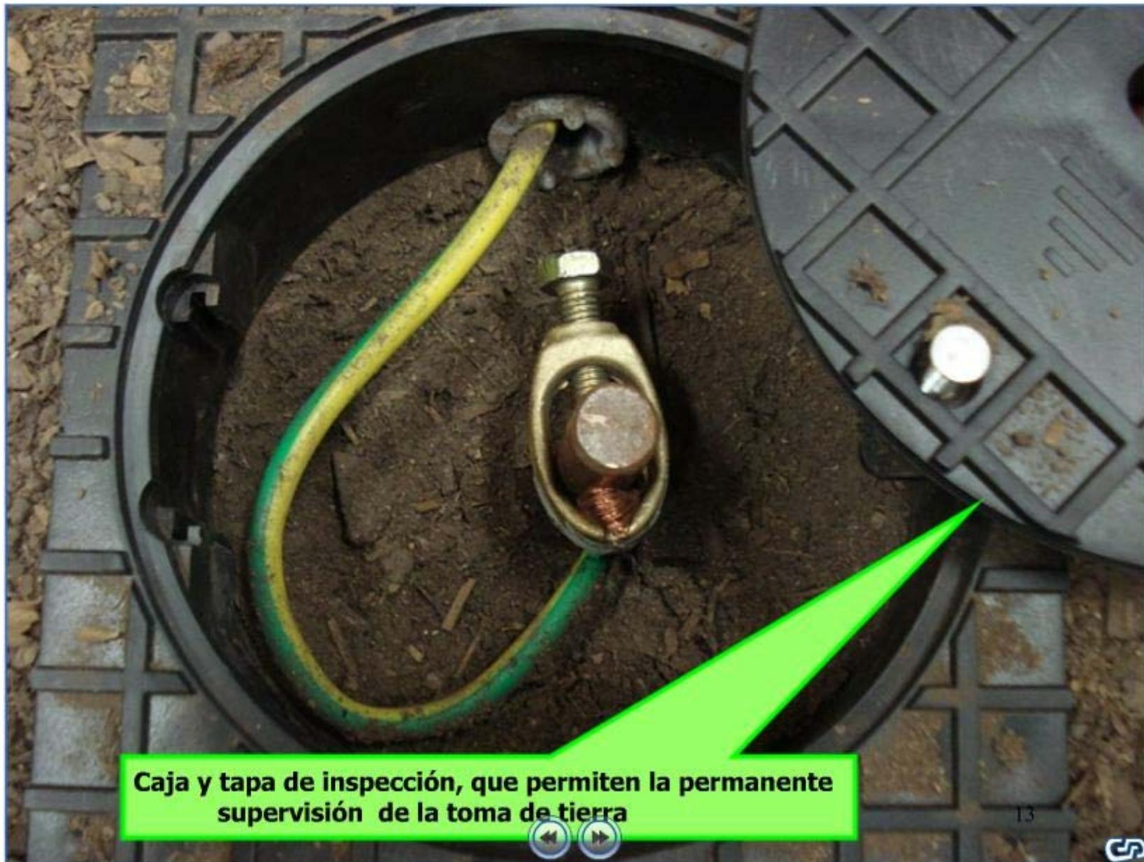
**Caja y tapa de inspección, que permiten la permanente supervisión de la toma de tierra**
