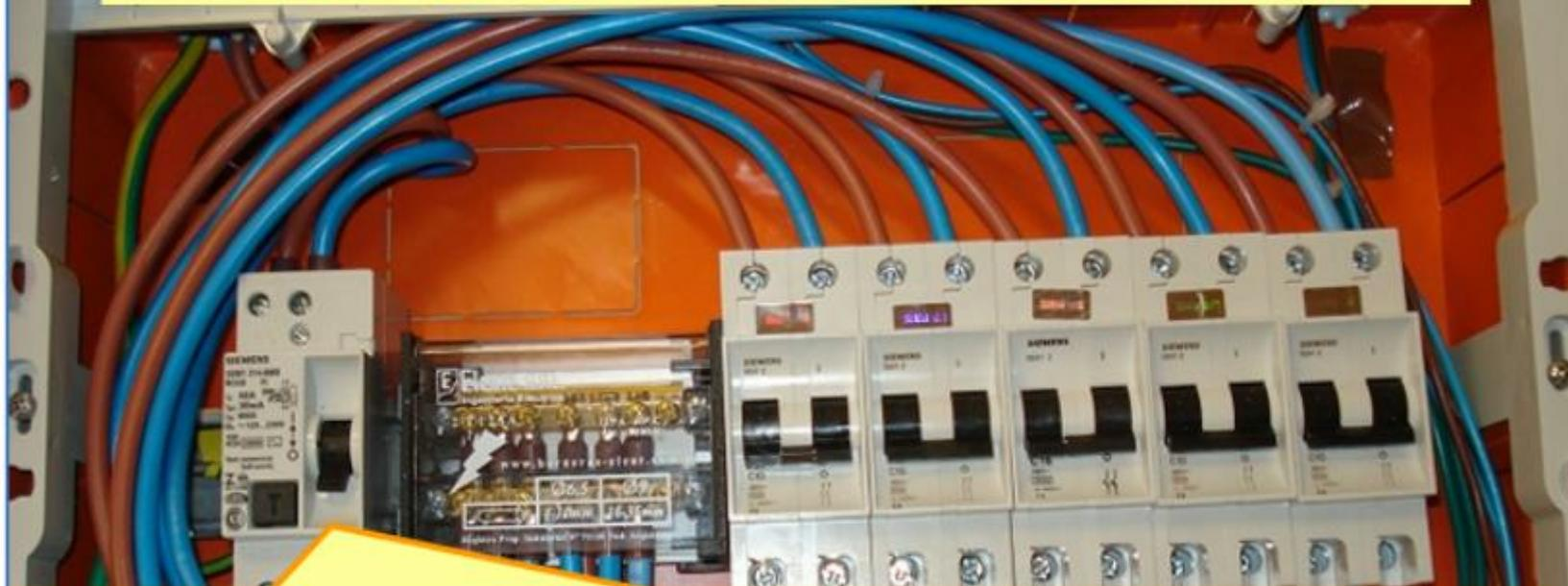
**Interruptor Diferencial, utilizado como corte de cabecera del Tablero seccional. Para la protección complementaria contra los contactos directos en los circuitos terminales la corriente diferencial de fuga no debe ser mayor a 30 mA y el tiempo de desconexión no superar los 200 ms.**
