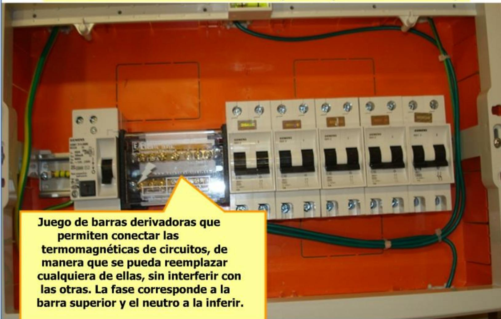
**Juego de barras derivadoras que permiten conectar las termomagnéticas de circuitos, de manera que se pueda reemplazar cualquiera de ellas, sin interferir con las otras. La fase corresponde a la barra superior y el neutro a la inferior.**
